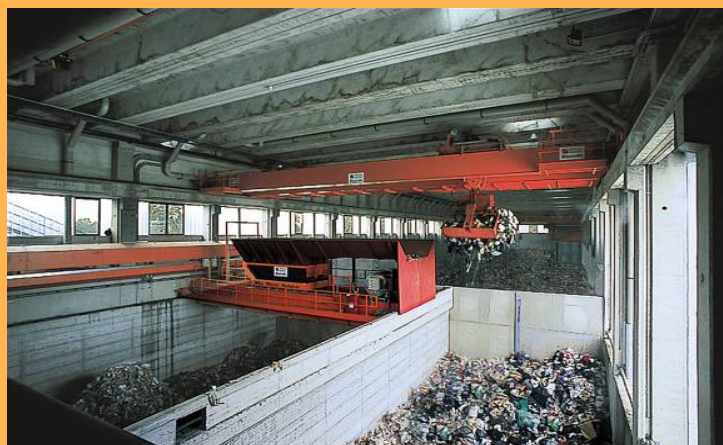
Βιολογική Ξήρανση σε δεξαμενή εντός κλειστού κτιρίου
